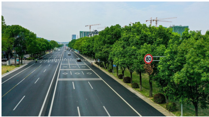
S214甬临线奉化段建设改造完成后,由原来的双向四车道改为双向六车道。
