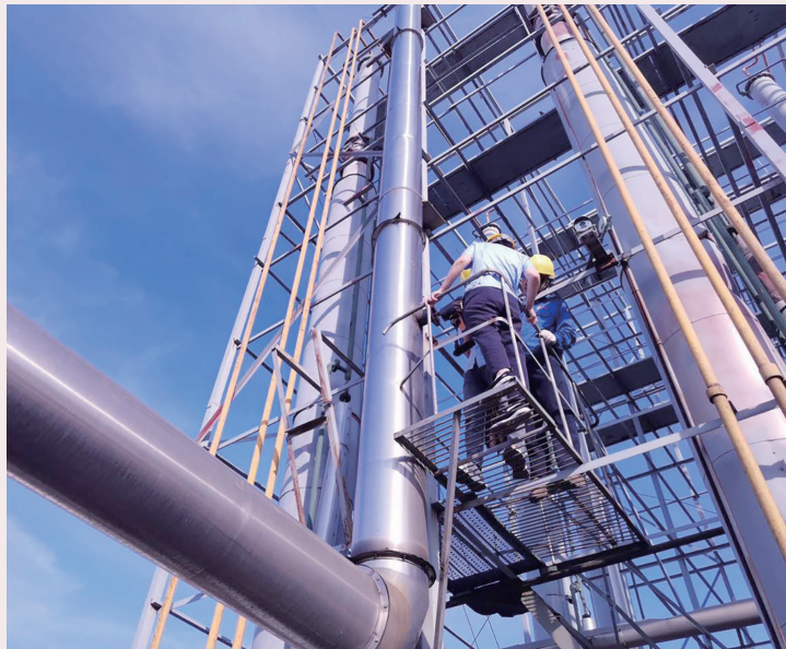
执法人员利用手持式挥发性气体检测仪对排放口数据进行检测
