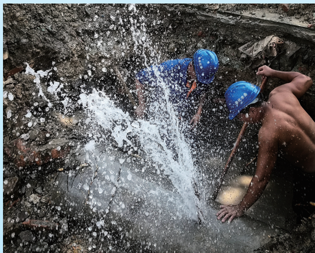
工作人员维修管网
