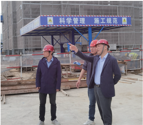
局领导带队检查部分在建项目施工安全防
