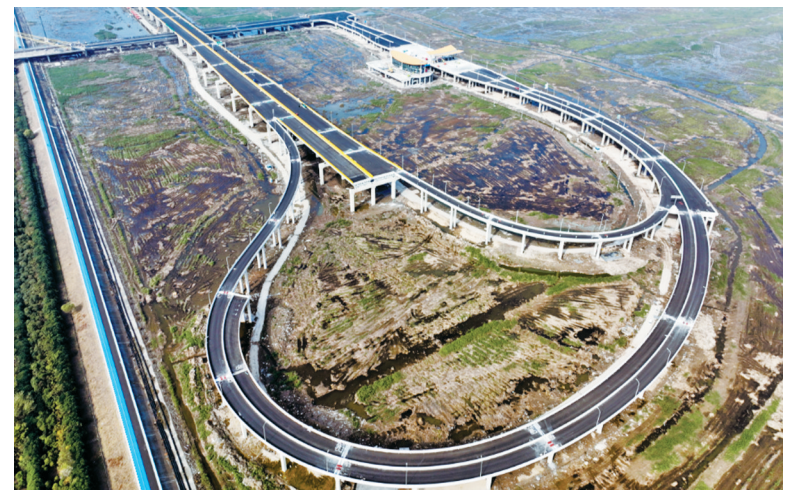
十一塘高速公路工程（一期）。
