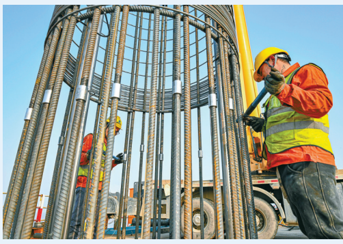
施工现场。(王嘉彬 摄)
