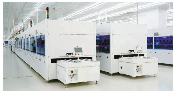
东方日升南滨基地生产车间
