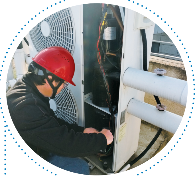
▲工人正在检测集中供热设备的性能。
