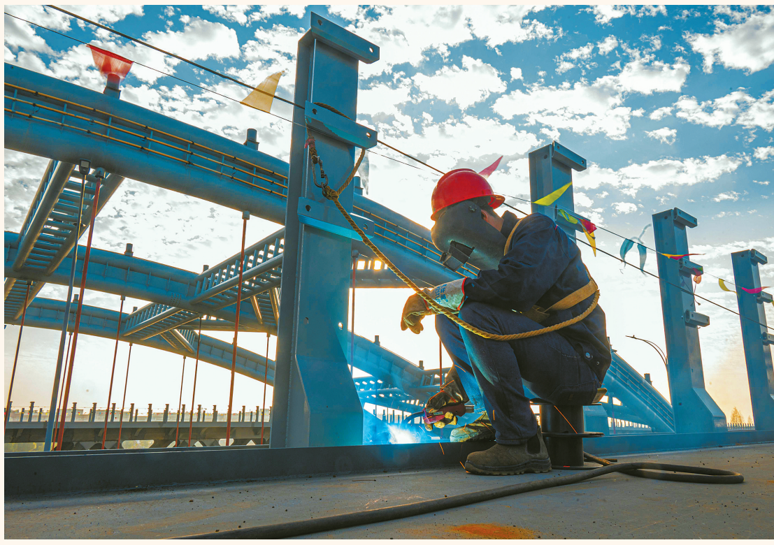
工人正在施工。
