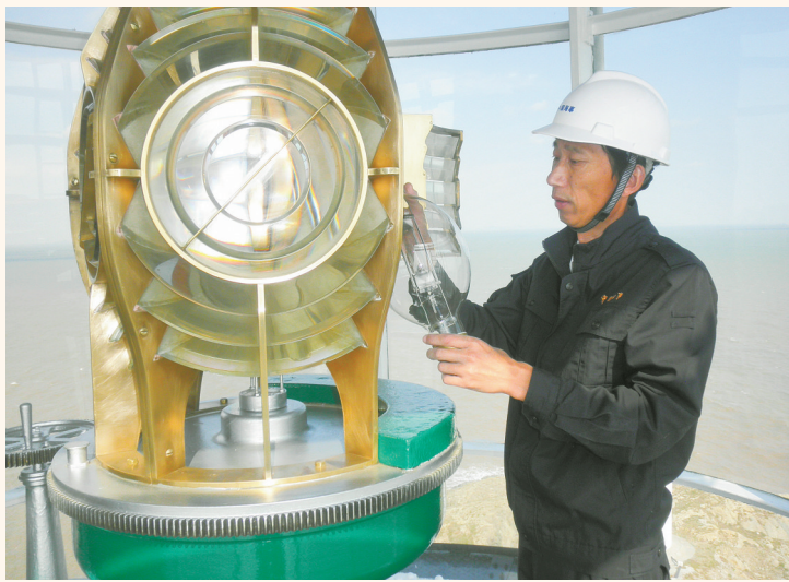
徐建国在检查灯塔设备。
