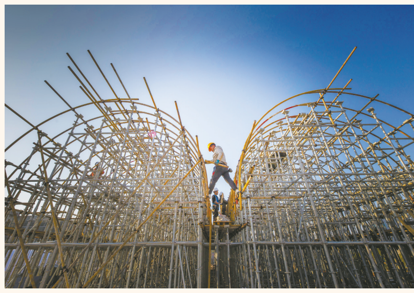
施工现场。(单柳青 摄)
