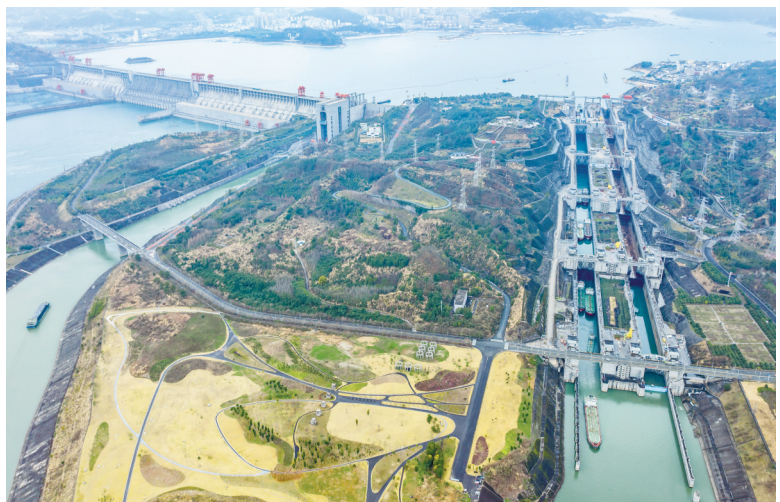
2月21日，三峡北线船闸进行检修施工（无人机照片）。（新华社发）
