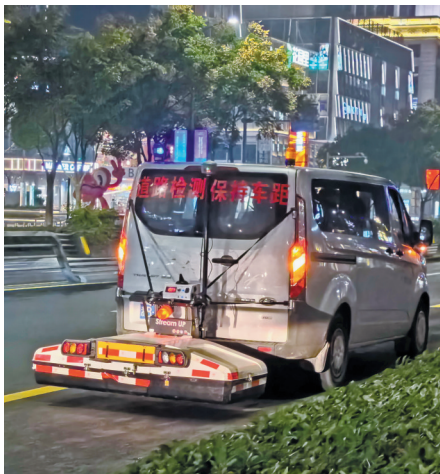
车载三维探地雷达探查道路地下情况。(余建文 应健 摄)
