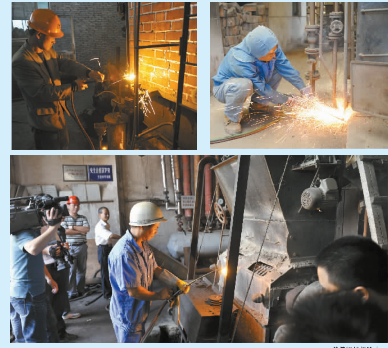
燃煤锅炉拆除中
