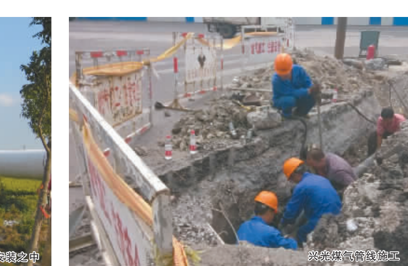
兴光燃气管道施工
