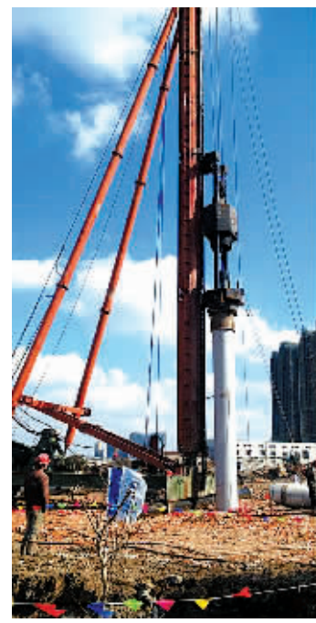
图为打桩现场。(厉晓杭 摄)
