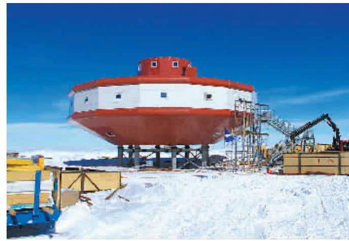
南极泰山站位于中山站与昆仑站之间的伊丽莎白公主地。这是1月24日拍摄的正在建设中的泰山站主体建筑。（新华社发）
