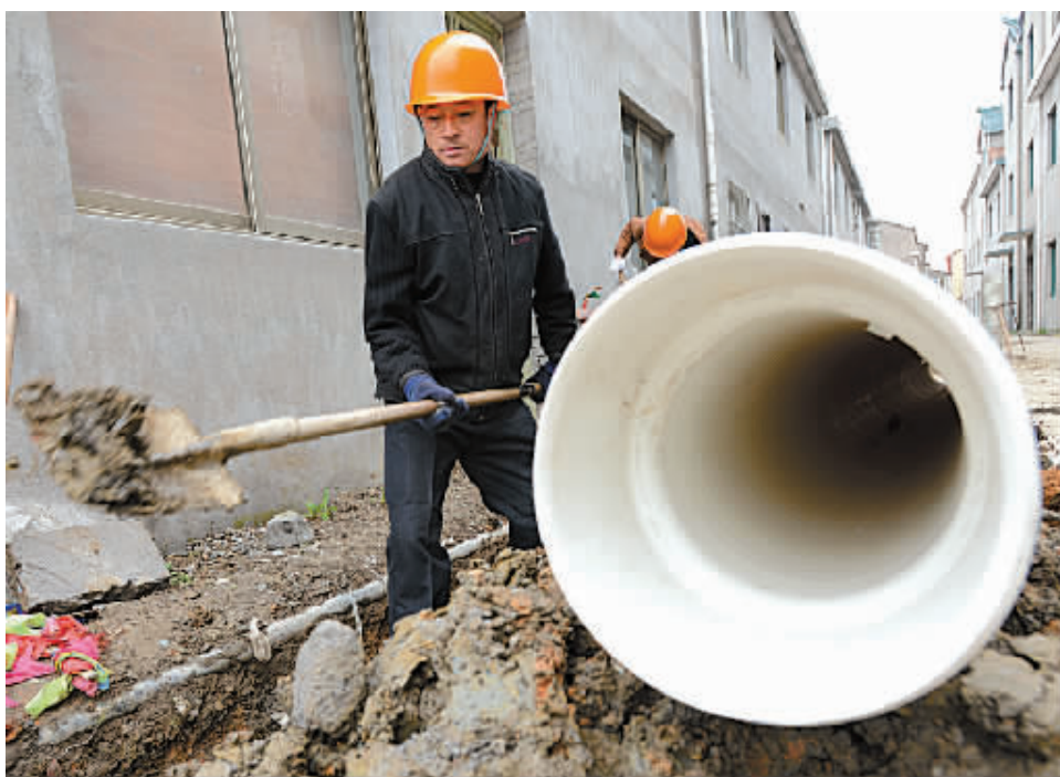
前天上午，施工人员在小港街道桥头严村铺设生活污水接户纳管管道。(徐能 金旭孟 摄)
