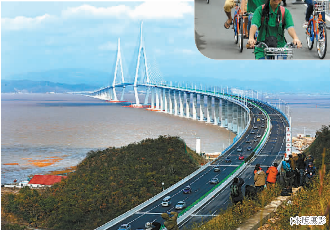
▲象山港大桥通车。
