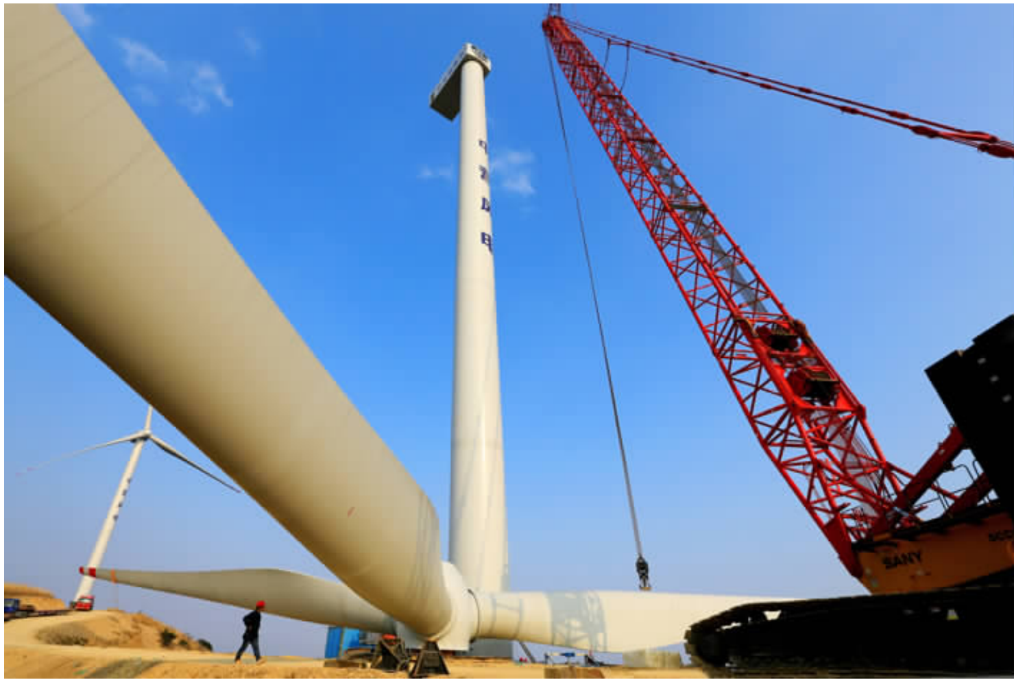
图为“大风车”的巨型叶片正准备由伸距100米的大型吊车吊升至80米高的发电机座。（记者 张跃 俞慧娜 摄）
