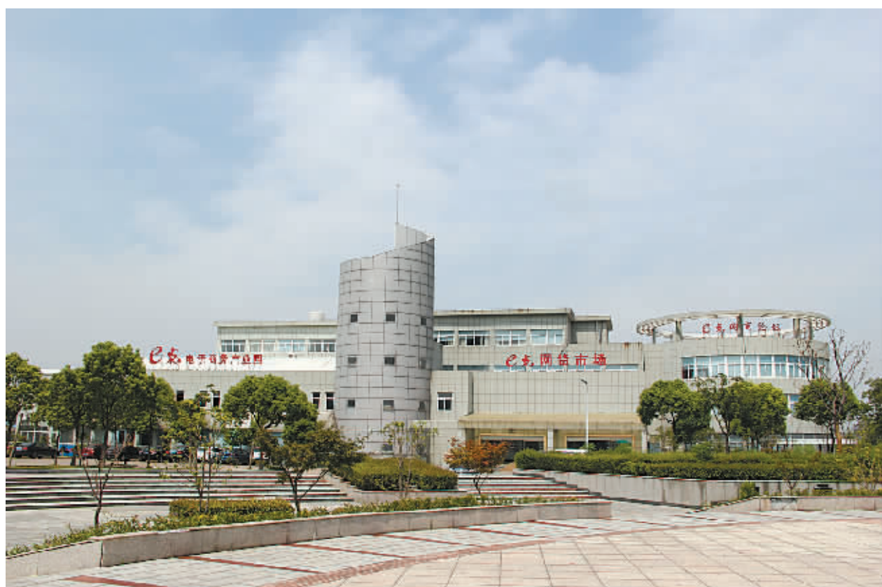
慈溪市e点电子商务产业园
