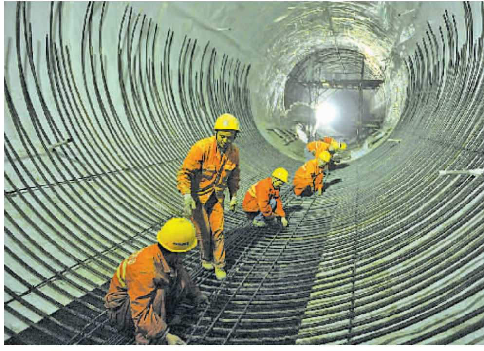
3月30日,施工人员在北京市南水北调东干渠五标已经贯通的地下隧道内绑扎钢筋。
