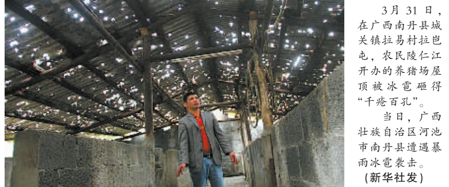
3月31日，在广西南丹县城关镇拉易村拉巴屯，农民陵仁江开办的养猪场屋顶被冰雹砸得“千疮百孔”。
