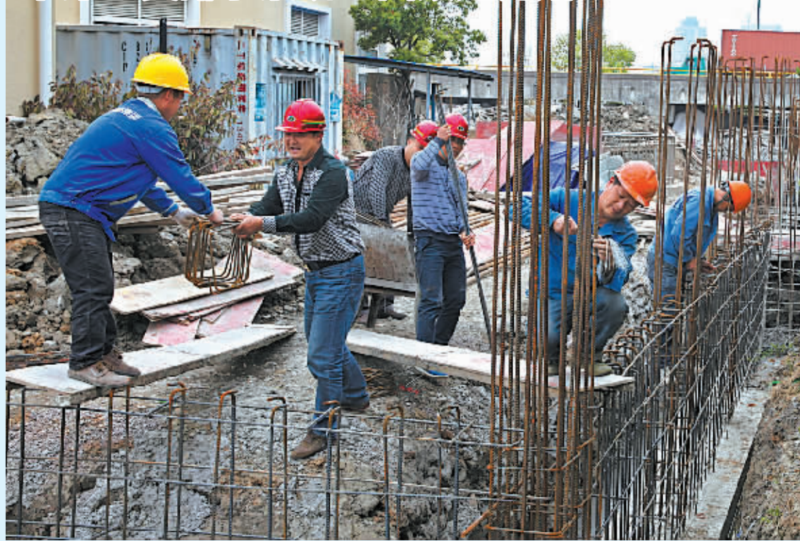
昨天下午，鄞州城管施工人员在鄞州大道下穿通道旁的桃江泵站改造工地绑扎钢筋，为周边浇筑防洪墙作准备。据市城管局介绍，今年，我市将对康庄南路、柳汀街、祖关山立交等17座立交和道路立交的排水系统及泵站进行全面改造，以提高防汛排涝能力。(胡建华 刘拥军 朱娇娇 摄)
