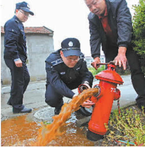
昨天，镇海区骆驼城管中队巡查人员对东钱村一处被撞歪的消防栓进行扶正维修和放水试验。自农村公共消防栓纳入属地城管管理以来，该城管中队定期巡查辖区20个村的288个公共消防栓，进行日常保养。
