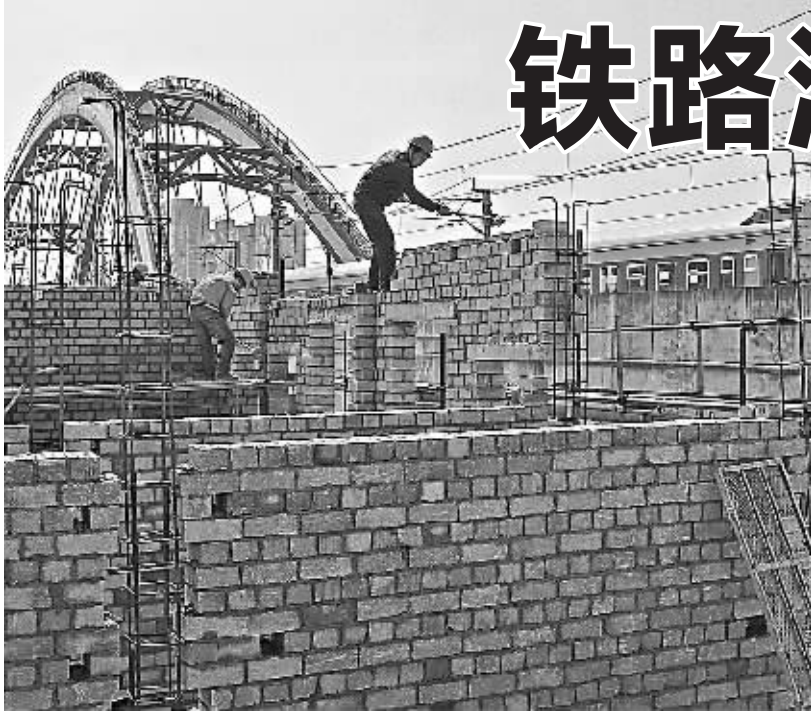
海曙城管部门在拆除上海铁路局宁波工务段新搭建的违法建筑。(胡建华 陈栋 摄)
