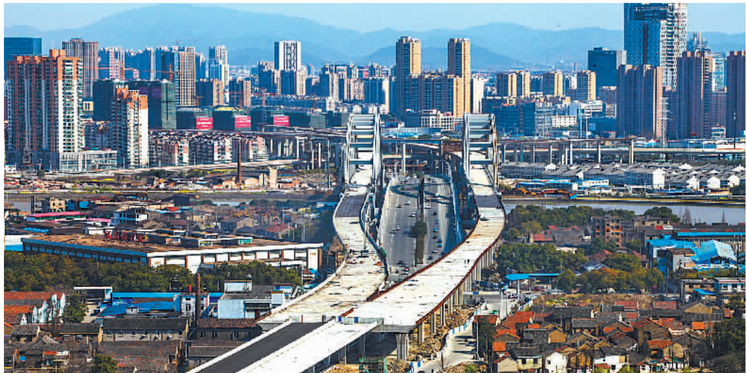
市民关注的环城南路快速路工程路面铺装施工全面展开。据宁波通途投资开发有限公司介绍，该快速路东起东苑立交，西至机场路，全长9.2公里，力争在今年10月建成。（胡建华 摄）
