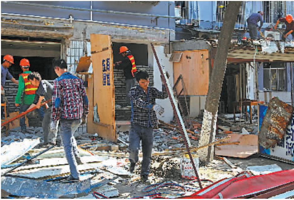
昨天下午，海曙区南门街道联合城管、公安等部门，对三市路南延伸段（甬水桥路至太平桥）沿街30间破窗开店的违建店面房进行强制封闭和拆除。（胡建华 陈栋 摄）
