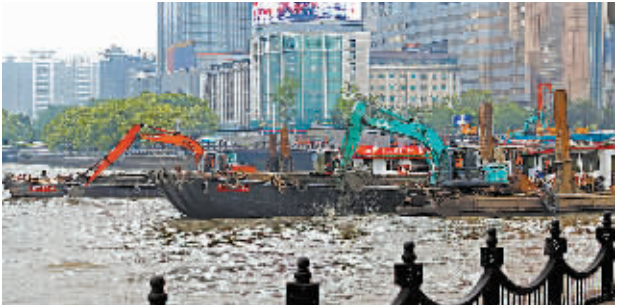
图为昨天上午在三江口区域进行的河道常态化清淤工程作业现场。（陈结生 严龙 摄）
