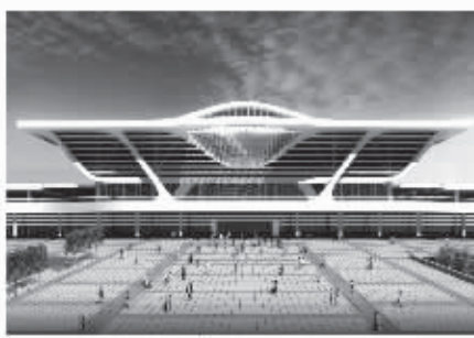
铁路宁波南站项目
