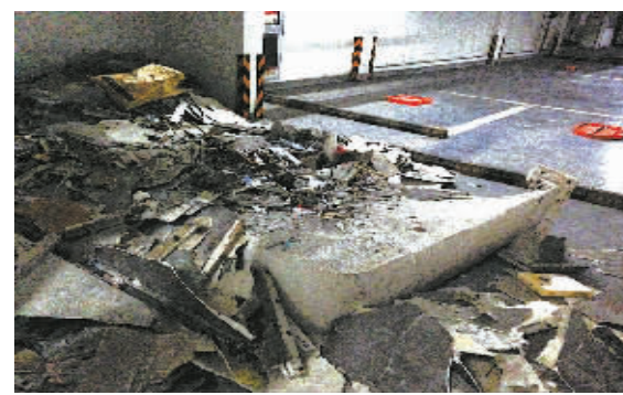
拆除的通风管堆在车位旁。(沈冲晖 摄)
