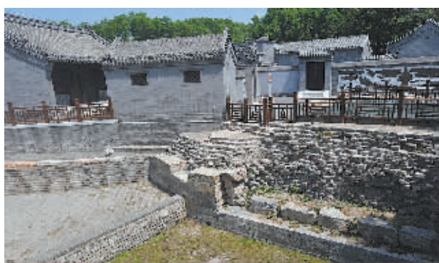
北京通惠河玉河遗址。(记者 周建平 摄)
