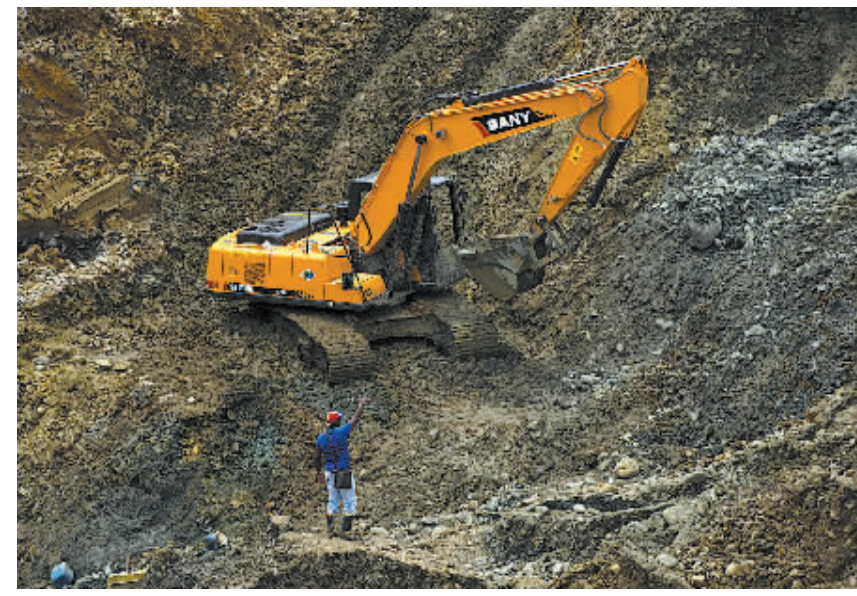
5月1日,在哥伦比亚的圣安东尼奥,挖掘机在发生塌方的金矿进行救援作业。当日,哥伦比亚圣安东尼奥的一个非法金矿发生塌方。当地救援官员介绍,事故已造成3人死亡,其余被埋的30余人还希望渺茫。(新华社/法新)
