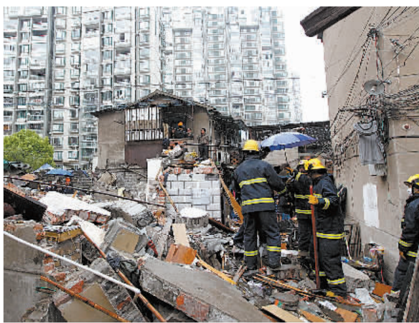
5月4日,上海虹口区新港路一老式居民楼因液化气钢瓶爆炸发生倒塌,已致2人死亡。(新华社发)
