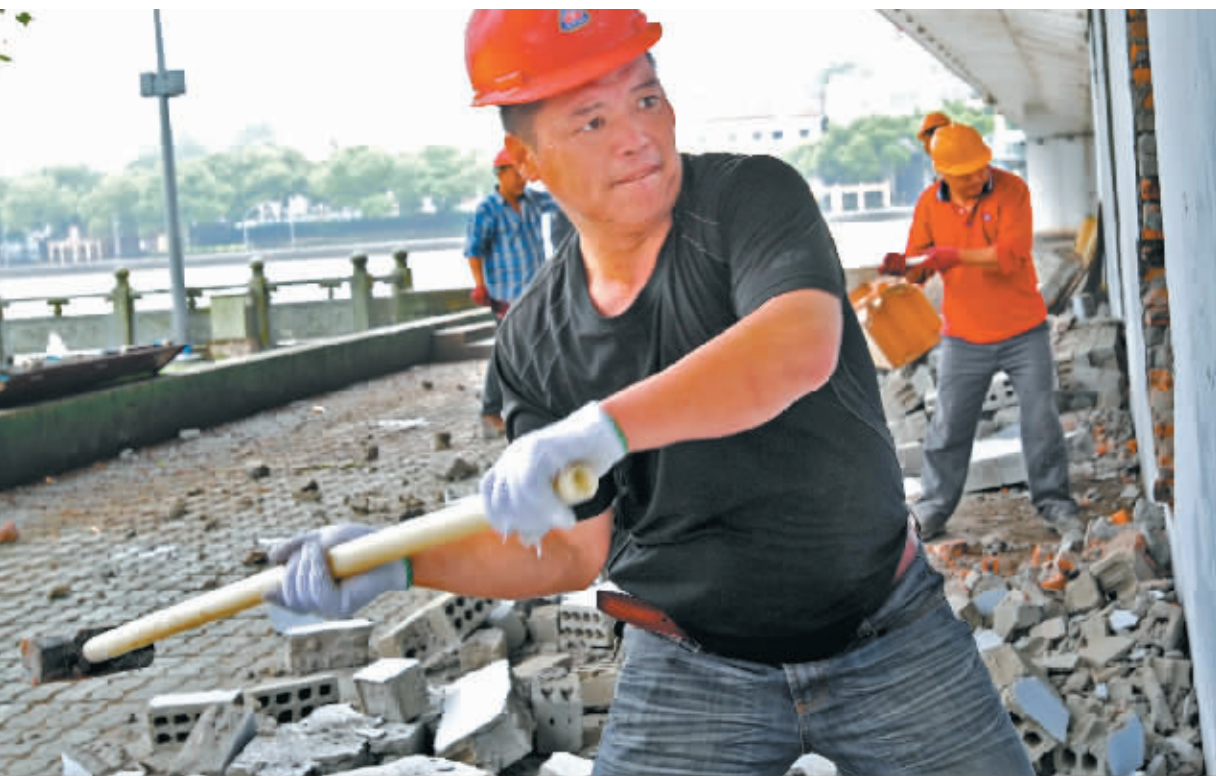
江东首拆涉江违建 昨天上午，江东区东胜街道、区城管部门联合拆除甬江大桥东侧桥洞内800余平方米违章建筑，消除大桥安全隐患，恢复周边社区流动人口的正常管理秩序，这也是江东区首次拆除涉江违建。（严龙 张绘薇 朱璐路 摄）
