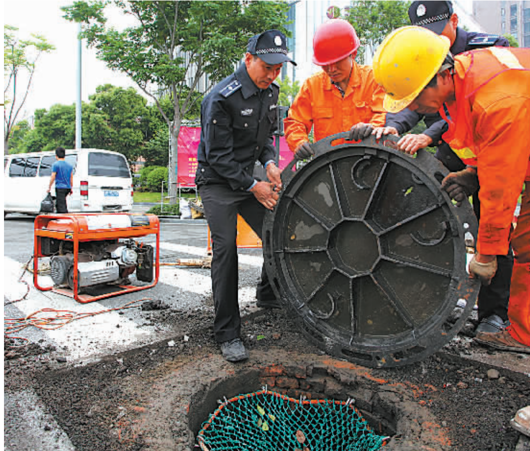
昨日，镇海区骆驼街道相关部门工作人员在更换骆驼西路、东邑北路一带的窞井盖。据该区域管理局介绍，新窞井盖具有防盗、不易破碎等特点，近期将在全区的主要道路上更新450套，以优化道路环境，保障市民出行安全。（胡建华 张寒 许诺 摄）
