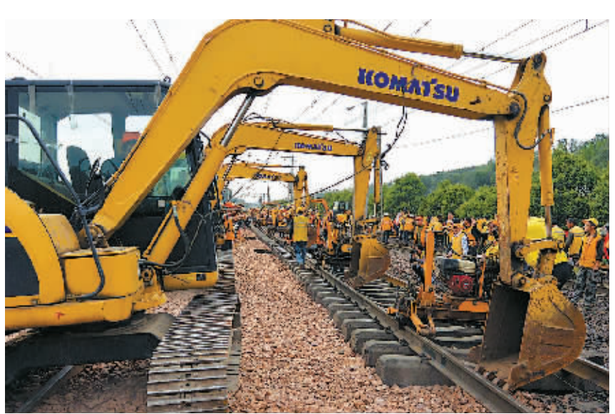
5月16日,在京广铁路与郑焦城际铁路黄河大桥的接轨地段,几台大型施工机械在推移钢轨。当日,黄河上首座四线铁路桥——郑焦城际铁路黄河大桥启用。已运行54年的京广铁路郑州黄河大桥(双线)正式“退役”。(新华社发)
