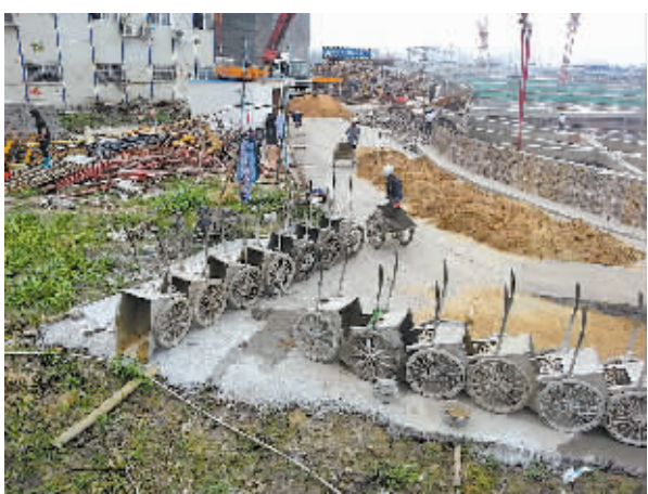
南面河道现在成了忙碌的工地。
