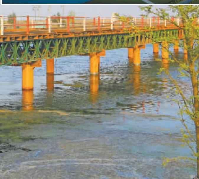
通向梅山岛的第二条通道——梅山春晓大桥今年1月3日正式开工以来,工程进展顺利,近日,记者在春晓明月湖边看到,几名工人正在梅山春晓大桥施工栈桥上铺设桥面。据梅山岛开发投资有限公司工程一部经理边疆介绍,现在大桥正在准备主墩钻孔桩施工,这条栈桥主要用于通往主墩施工现场。
