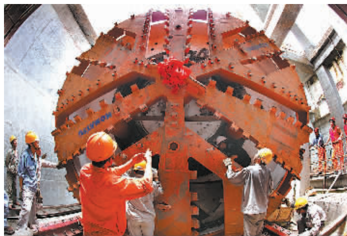
轨道交通首台盾构机在福明路站下井。
