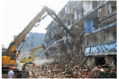
危房拆除现场。(周建平 摄)
