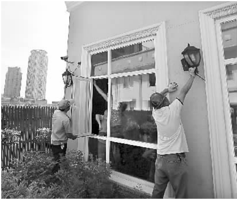
图为拆建人员在拆除空中别墅窗户及壁灯。(陈栋 胡建华 摄)
