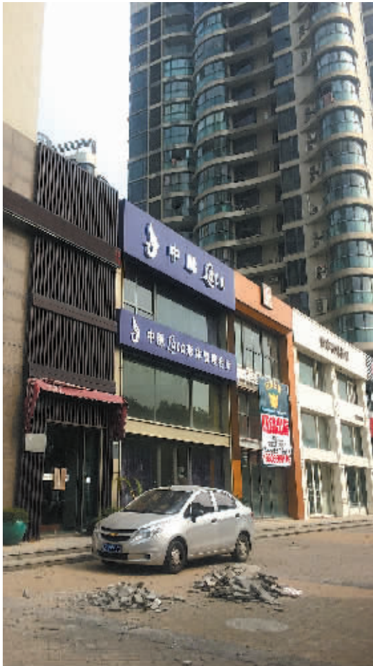
养生馆门前还停着阻止施工的车，地面上堆着从墙体上敲下的碎石块。(王伊婧 摄)
