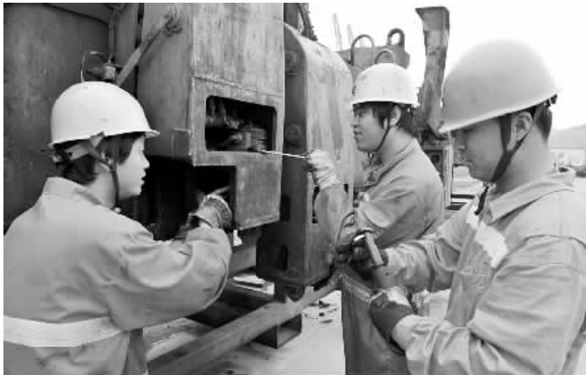
图为王海波工作室成员在现场进行桥吊RAW吊具中锁着箱机构改造。(严雷 摄)
