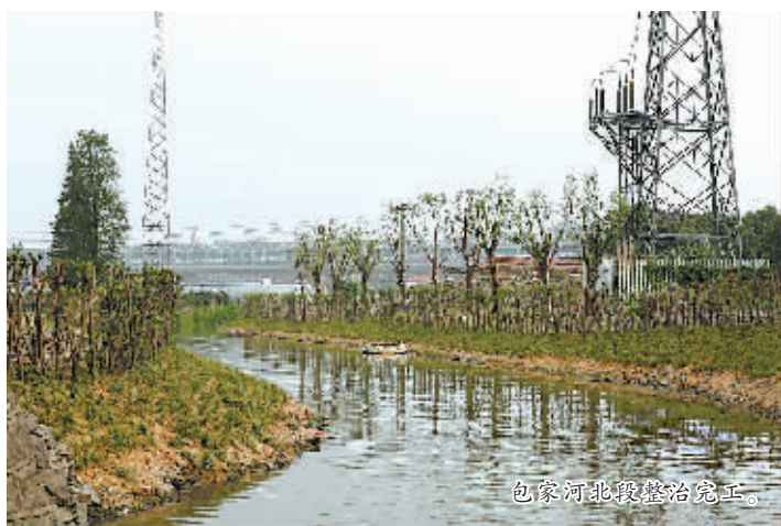
包家河北段整治完工。
