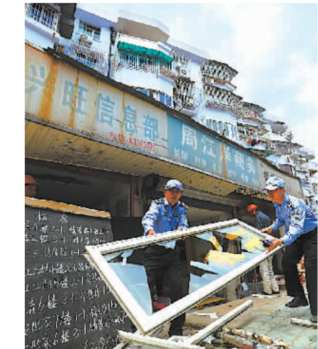
三市路22间违法店面房近日被拆除。
