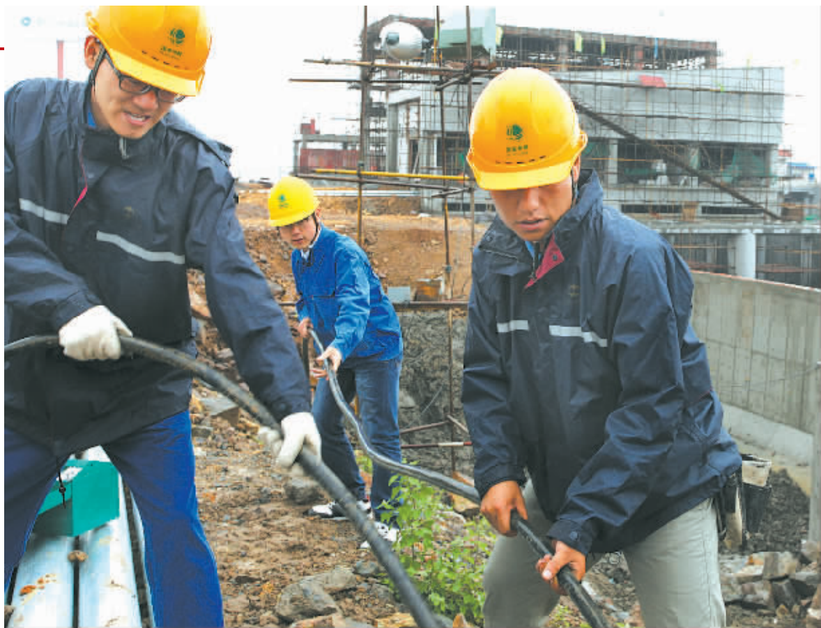
▲昨日,在镇海区新弘口排涝泵站工地,宁波供电公司镇海客户服务分中心的员工正在加紧作业,为2000千瓦专变施工作最后的准备。市供电部门专门为该水利应急工程建设开辟绿色通道,2条10千伏专线将于本月底前完工,确保该排涝泵站在7月15日主汛期前投入使用。(胡建华 邵晓刚 朱日彬 摄)
