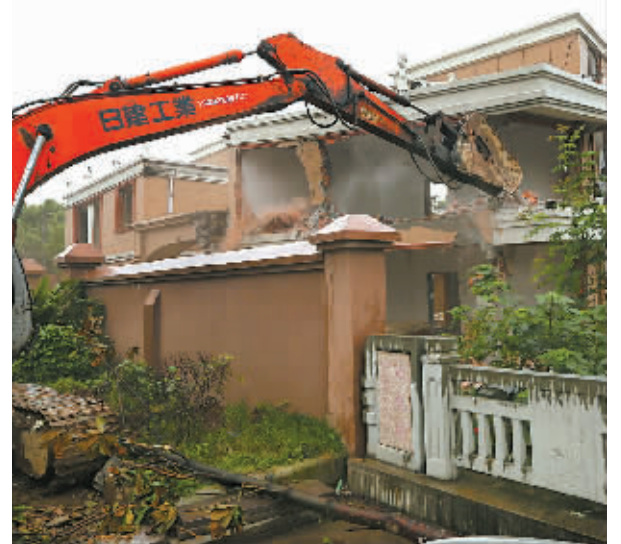
图为违建别墅被拆除。(胡建华 陈栋 摄)
