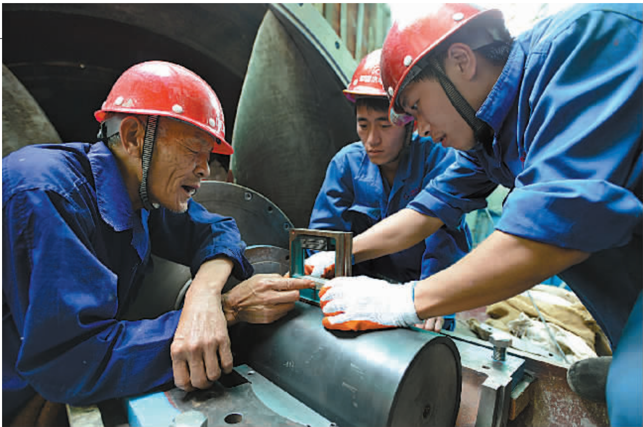
75岁、有着50多年安装经验的吴师傅(左一),前天应邀为鄞州区铜盆浦泵站做水泵机组精调。作为我市应急抢修工程之一,铜盆浦泵站工程是鄞东南平原防洪排涝体系中的重要排涝设施,预计本月底前具备通水条件。(徐能 赖淑萍 续大治 摄)
