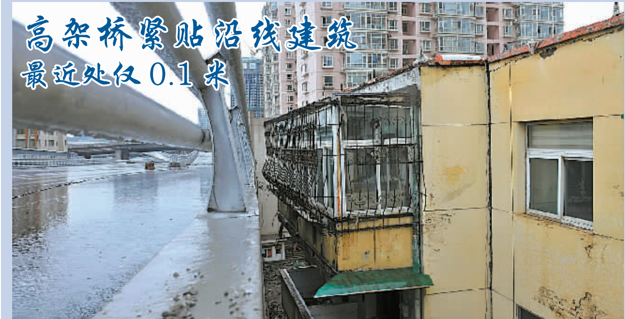
太原市元中元小区1号楼六层的建筑和高架桥距离不足一米（7月9日摄）。近日，记者在山西太原市杏花岭区走访发现，位于太原市北中环街和洞河路交叉口在建高架桥部分桥面离沿线建筑过近，高架桥护栏和建筑“亲密无间”地贴在一起，最近处距离仅0.1米左右。（新华社发）
