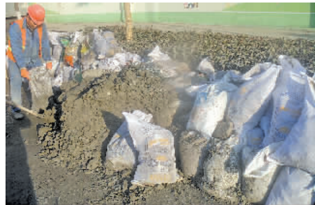
嵩江路雨水管中抠出的大量淤泥，工人正在装袋准备清运。(资料图片)
