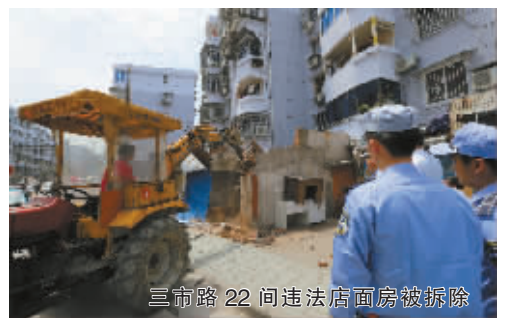
三市路22间违法店面房被拆除
