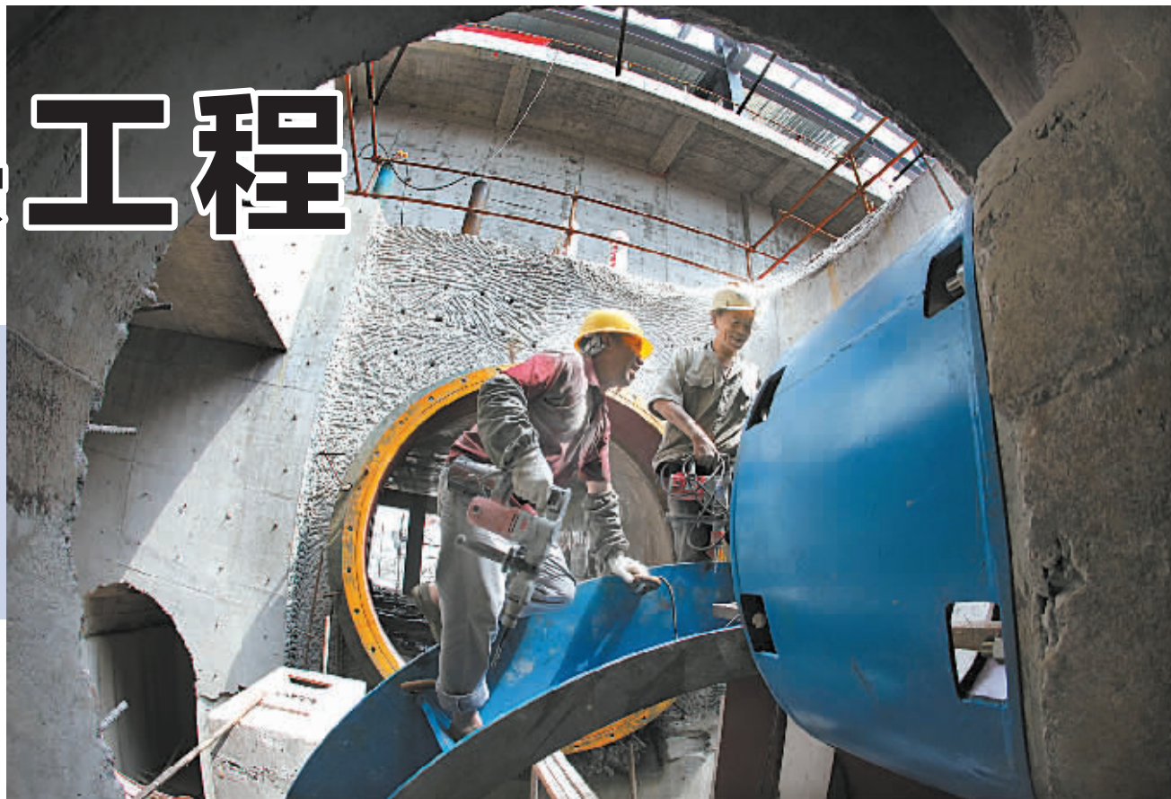
余姚市陶家路江西门泵站机组安装基本到位。
